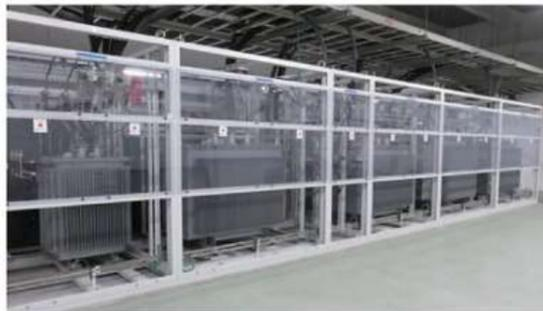
高効率の変圧器へ更新。新輪転機の電源もバッチリです。
