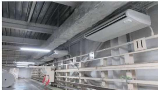
ダイキン製の最新型エアコンへ更新し、省エネ化を図るとともにBEMS(ビル・エネルギー・マネジメント・システム)と連動して契約電力を抑えるように設計、施工しました。
